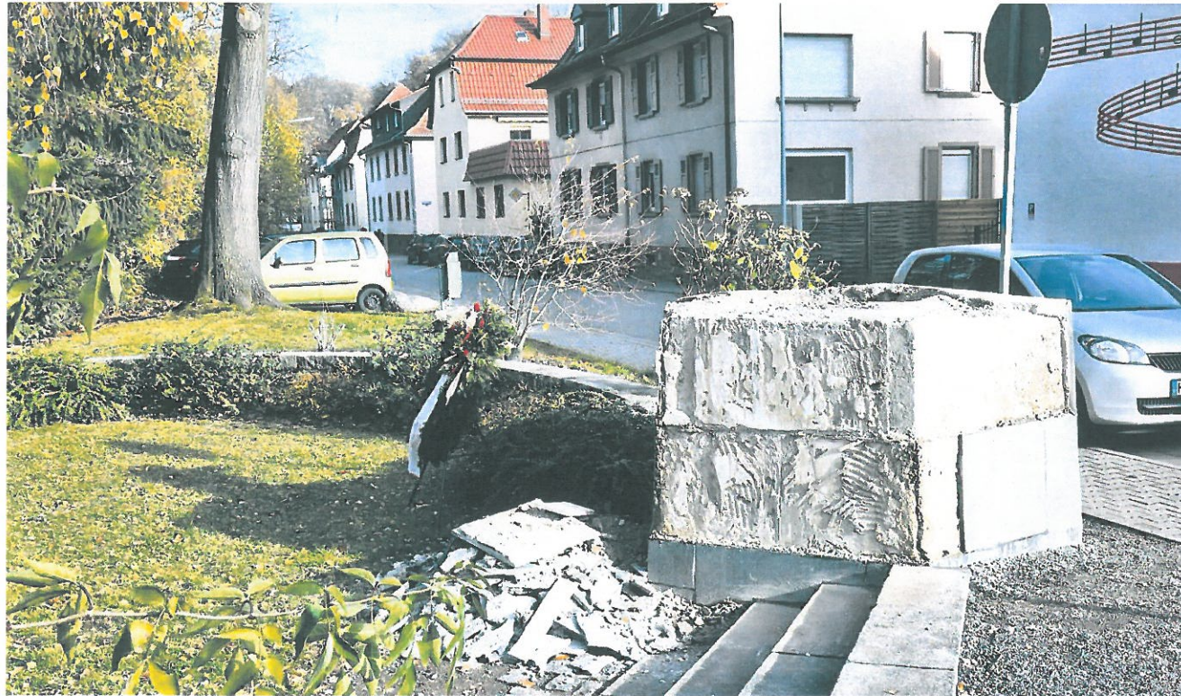
Das Kriegerdenkmal wird von der Hornbacher Straße in den alten Friedhof in der Kirchgasse verlegt. Die Verlegung des Denkmals und die Umgestaltung der Grünanlage am Julius-Brunnen hatten die Birkenauer Mandatsträger in ihrer Sitzung im Juni dieses Jahres beschlossen. Unser Bild entstand am Mittwoch, bereits am Dienstag wurde begonnen, das Kriegerdenkmal abzubauen. BILD: FRITZ KOPETZKY
